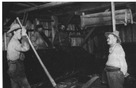
4. Des travailleurs à l'intérieur d'un moulin à scie à Kiamika. Source : Kiamika comme une rivière... , p.384.
